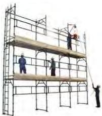
✓ **Andaimes Fachadeiros** – são formados por quadros verticais e horizontais, placa de base, travessa diagonal, tela, guarda-corpo e escada. São andaimes muito utilizados em áreas da construção civil como a construção e a manutenção de fachadas. Estas estruturas permitem o acesso de pessoas, mas também de materiais à obra.
